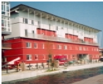
Trähus 2001, Västra hamnen, Malmö, som har boendesprinkler och träfasad.
